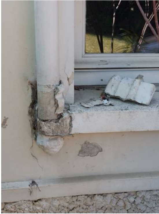
1 : Appui de baie RDC
