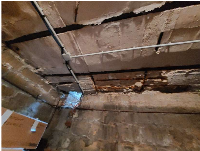
Images 13 : Plancher haut du sous-sol
